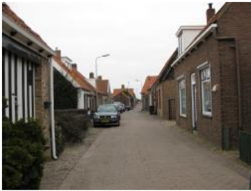
(afb. 2.20. 2010. Foto auteur. Dijkwoningen in Nieuw- en Sint Joosland)
