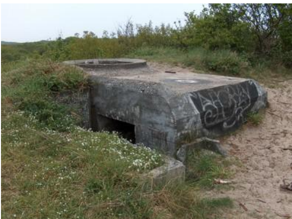
(afb. 7.4. www.bunkerbehoud.com . Bij Vrouwenpolder liggen, langs de Vroondijk, de restanten van Stützpunkt "Emmerich", twee tobroeke van het type 58c)
