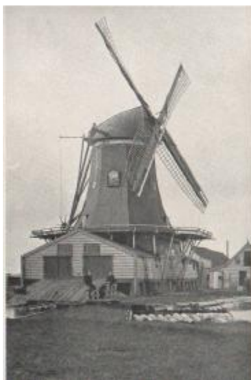
(afb. 4 III.12. Polderdijk 1936. Foto's van houtzaagmolens in de Zaagmolenpolder, Links; type bovenkruier. Rechts; type paltrok. De balkhavens zijn te onderscheiden en de bijgebouwen)
