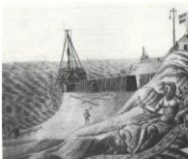
(afb. 3 IV.4. Beenhakker, 1996. Detail van een kaart waarop te zien is hoe paalhoofden gebouwd werden, in dit geval bij een wachthuis met seinpost en vuurbaken)
